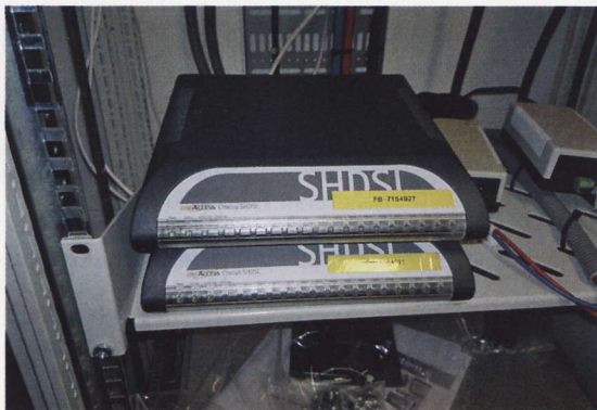
Модемы для подключения БС к транспортной сети
